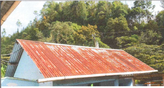
Foto 3: Sustitución de lámina acanalada por lamina troquelada en área de cocina.
