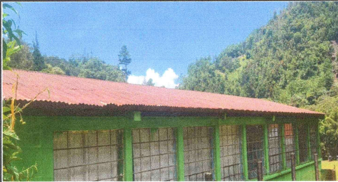
Foto1: Sustitución de lámina acanalada en mal estado por lámina troquelada. Así mismo instalación de canales de metal con sus respectivos pescantes.
