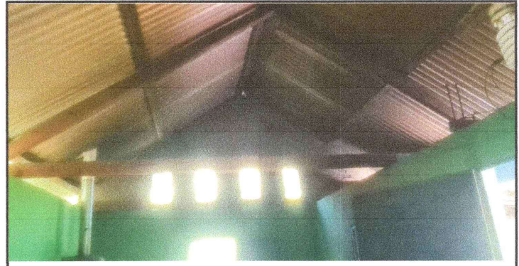
Foto 4: Sustitución de estructura de madera por estructura de metal.
