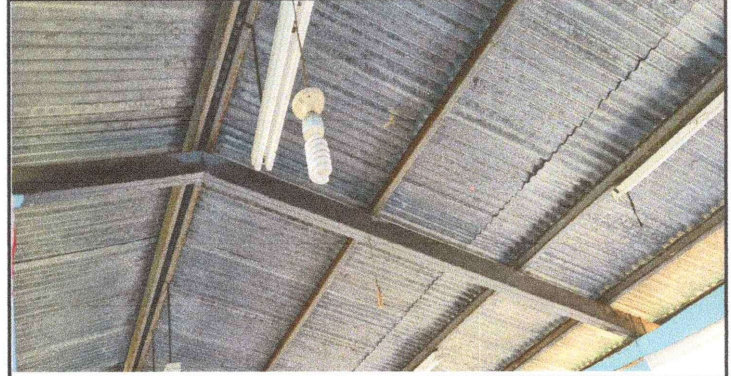
Foto 2: Mantenimiento de estructura de metal para mayor vida util (lijado y pintado).
