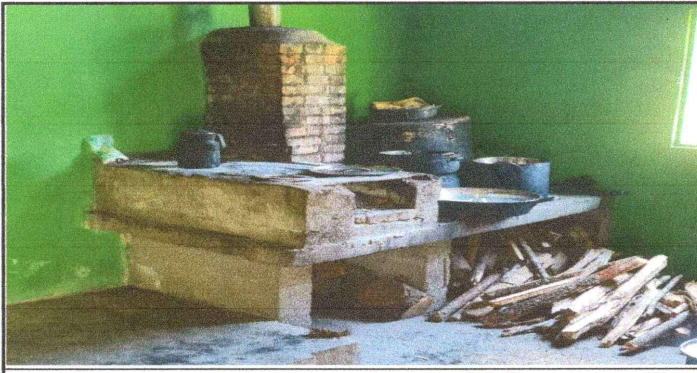
Foto 5: Mejoramiento de polleton e instalación de parrillas de metal.
